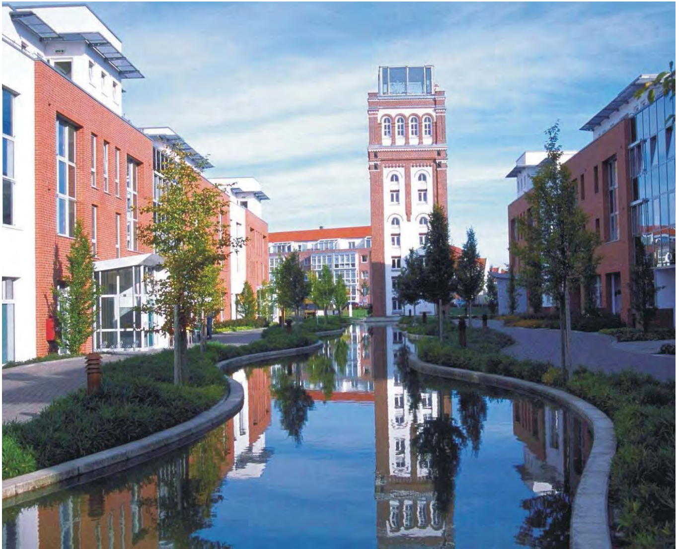
Das Wohngebiet am Povelturm in Nordhorn, Beispiel einer gelungenen Umnutzung von „Industriebrache“
