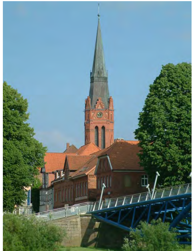
Nienburg: die neue Fußgängerbrücke über die Weser mit der Weserstraße und der St. Martinskirche
