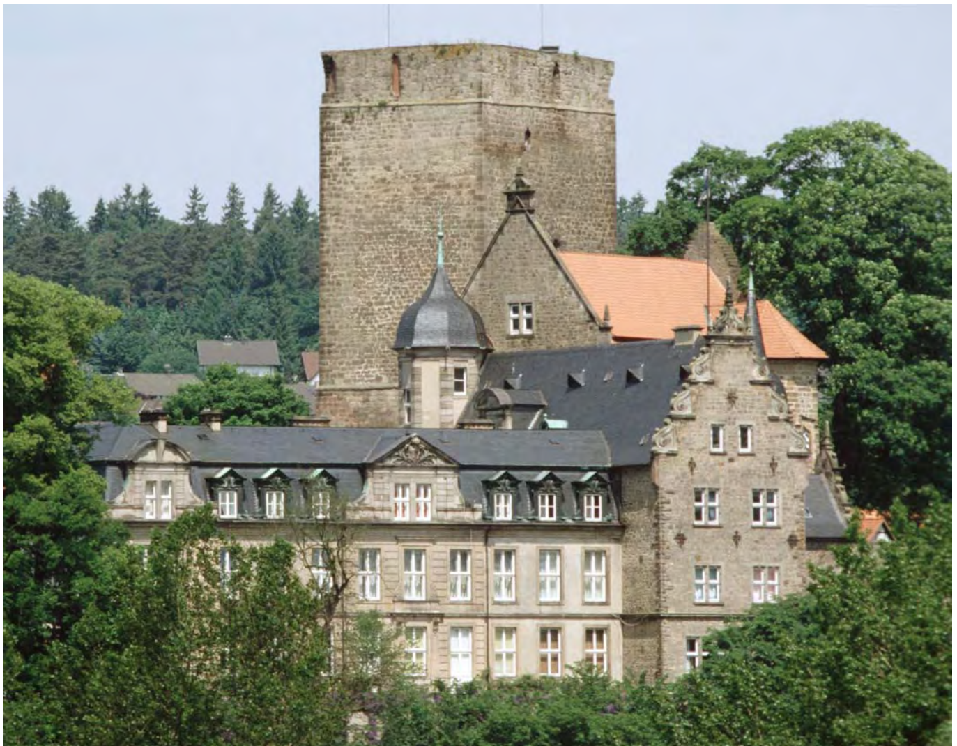
Die Burg Adelebsen, eines der herausragenden Baudenkmale im Landkreis
