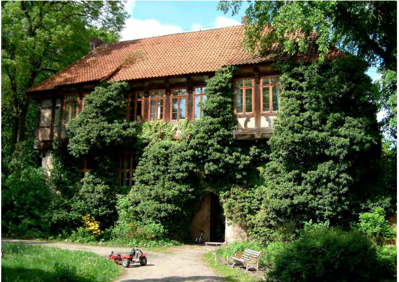
Das Renaissance-Castrum des Rittergutes im Dorf Brokeloh, dem Bundessieger 2004 des Wettbewerbs „Unser Dorf soll schöner werden - Unser Dorf hat Zukunft“
