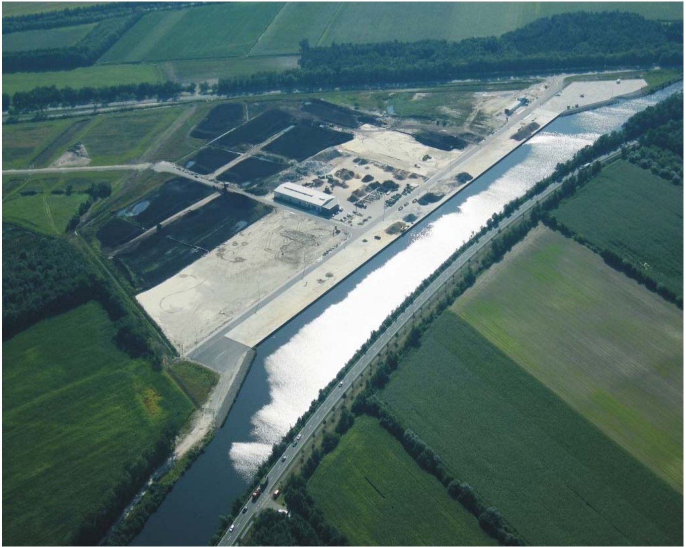
Infrastrukturausbau: der „c-Port“ am Küstenkanal
