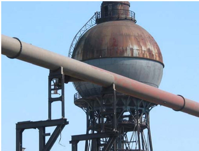
Industrielles Erbe: Kugelwasserturm auf dem Gelände der Ilseeder Hütte
